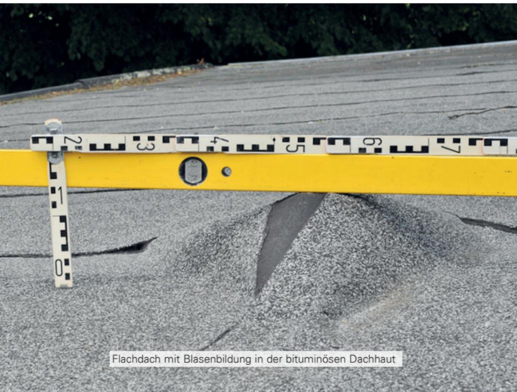
Flachdach mit Blasenbildung in der bituminösen Dachhaut
