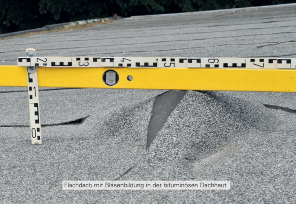
Flachdach mit Blasenbildung in der bituminösen Dachhaut
